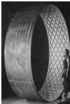
Троугаони тип (ISOGRID панел)
